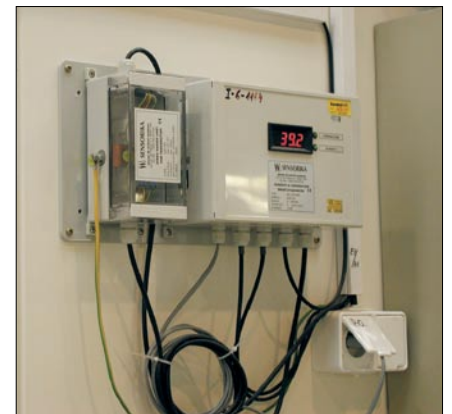
Obr. 2. Pohled na měřicí sestavu jednotky Zenerových bariér a hygrometru pro řízení parního zvlhčovače stříkacího boxu lakovny
