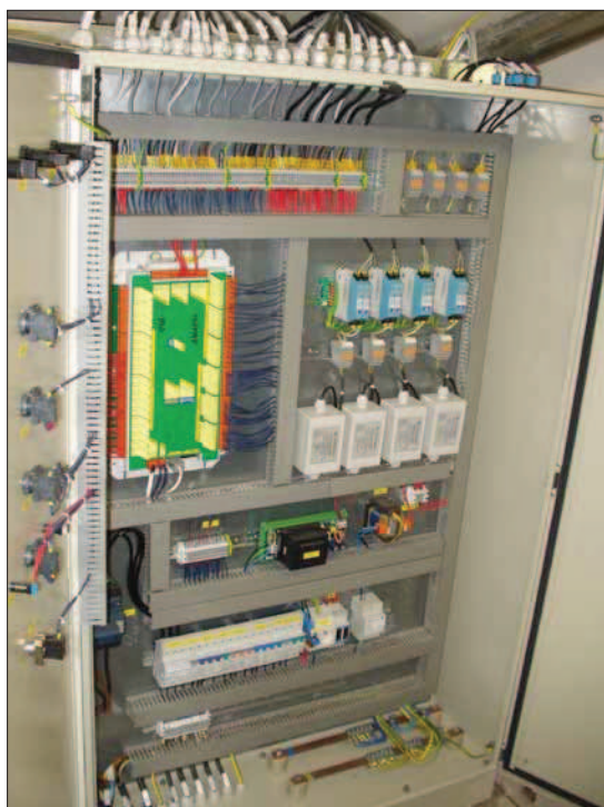
Obr. 14. Rozváděč sdružující čtyři měřicí kanály pro měření vlhkosti prostředí průmyslové lakovny
